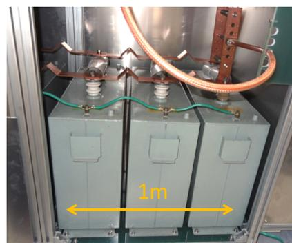
図 B.8: コンデンサバンクの内部の写真。 $C=0.25\text{ [mF]}$  のコンデンサが3つ写っており、これが合計12個、 $3.0\text{ [mF]}$  の静電容量を持つ。
