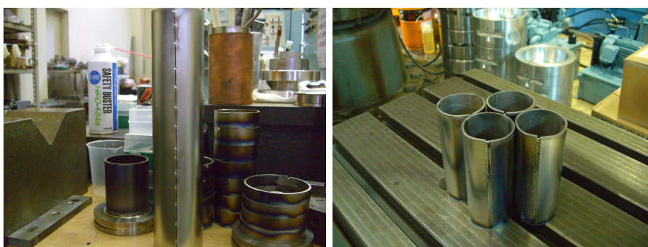
図 3.9: ビームパイプの溶接
