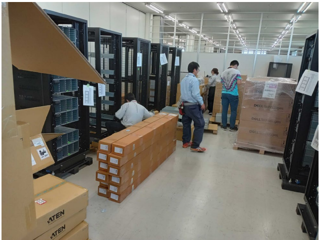
写真 1. 第 7 期システム構築作業
