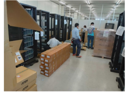
写真11：第7期システム構築作業
