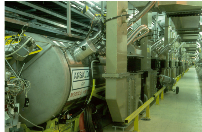
電子・陽電子を加速するための 超伝導加速管
