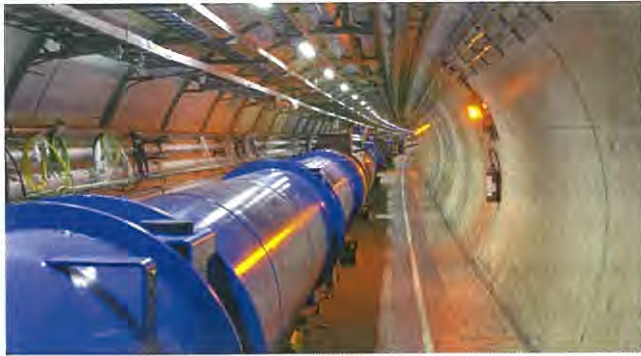
図4 LHCトンネル内部の写真：(地下100 m. 1周27 km). 青い管が加速管。
